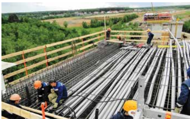
Обустройство ливневой канализации
