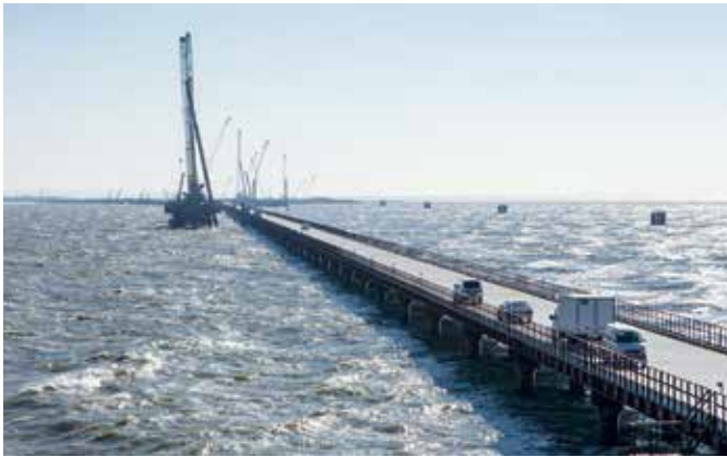
Строительство Крымского моста
