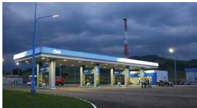
АГНКС в Горно-Алтайске
