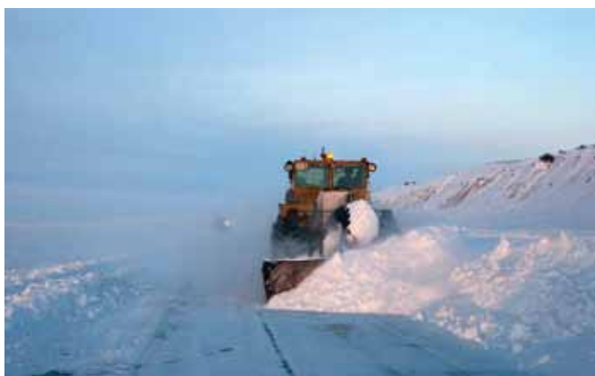
Работы по устройству автозимника Батагай - Сайды
