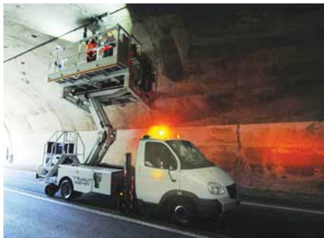
Tunlift 737-500 во время обслуживания тоннеля
