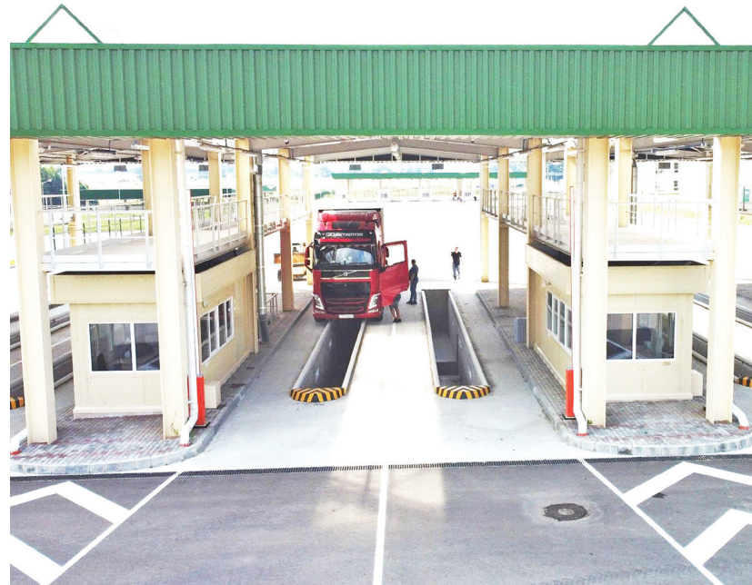
Автомобильный пункт пропуска Дубки в Калининградской области
