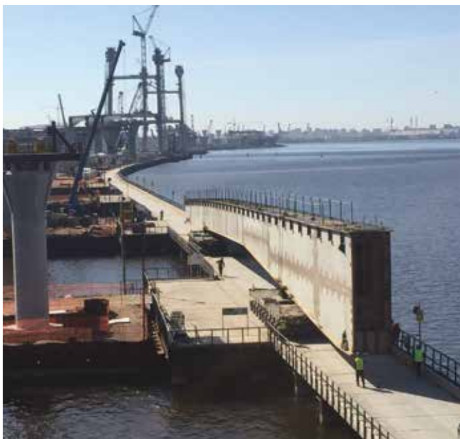
Перевозка пролетных строений Западного скоростного диаметра в Санкт-Петербурге длиной 105 м весом 285 т
