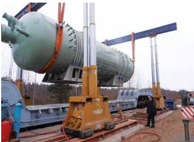
Погрузо-разгрузочные, монтажные и такелажные работы производятся с использованием собственных мобильных гидравлических порталных систем грузоподъемностью до 1000 т и вспомогательного оборудования
