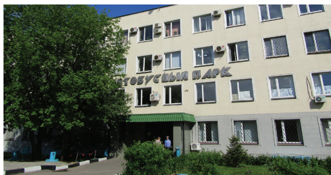
Административное здание 17-го Автобусного парка
