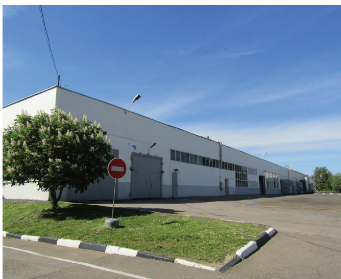
Здание для проведения ТО и Р автобусов
