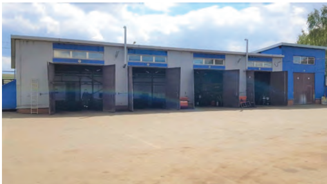
Боксы для технического обслуживания подвижного состава
